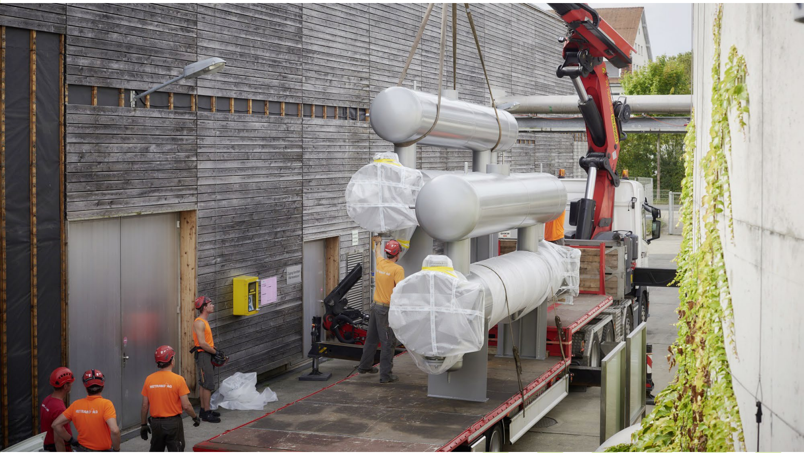
Einbau der Wärmepumpen.
